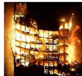
یک ساختمان در حال آوار بدون حفاظت سازه در برابر حریق
