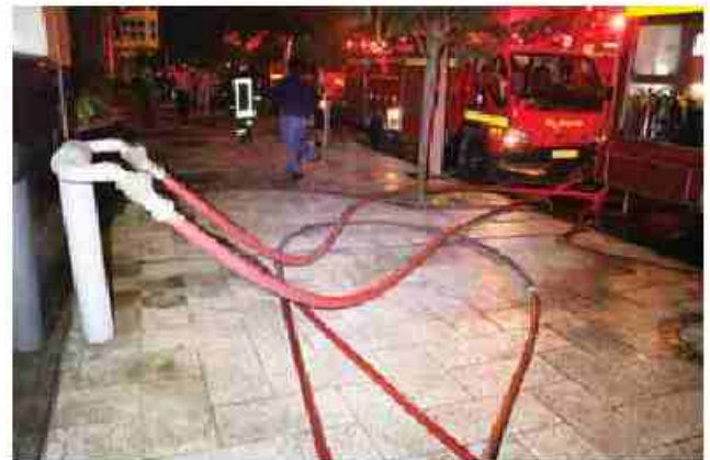
شکل (۸): عملکرد مثبت و بهره‌وری عملیات با استفاده از رایزرهای خشک در آتش‌سوزی برج سلمان مشهد
