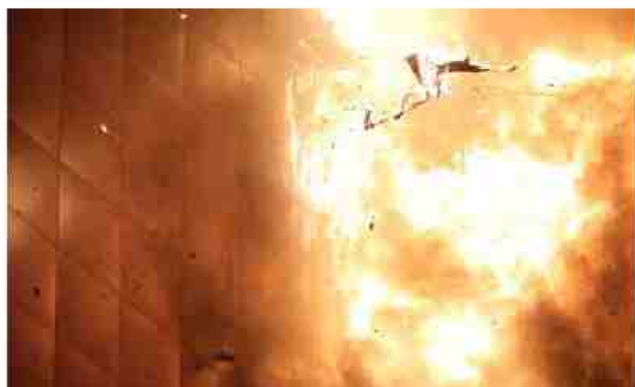
شکل (۳): پرتاب گدازه‌های آتش و قطعات شعله‌ور نمای کامپوزیت
