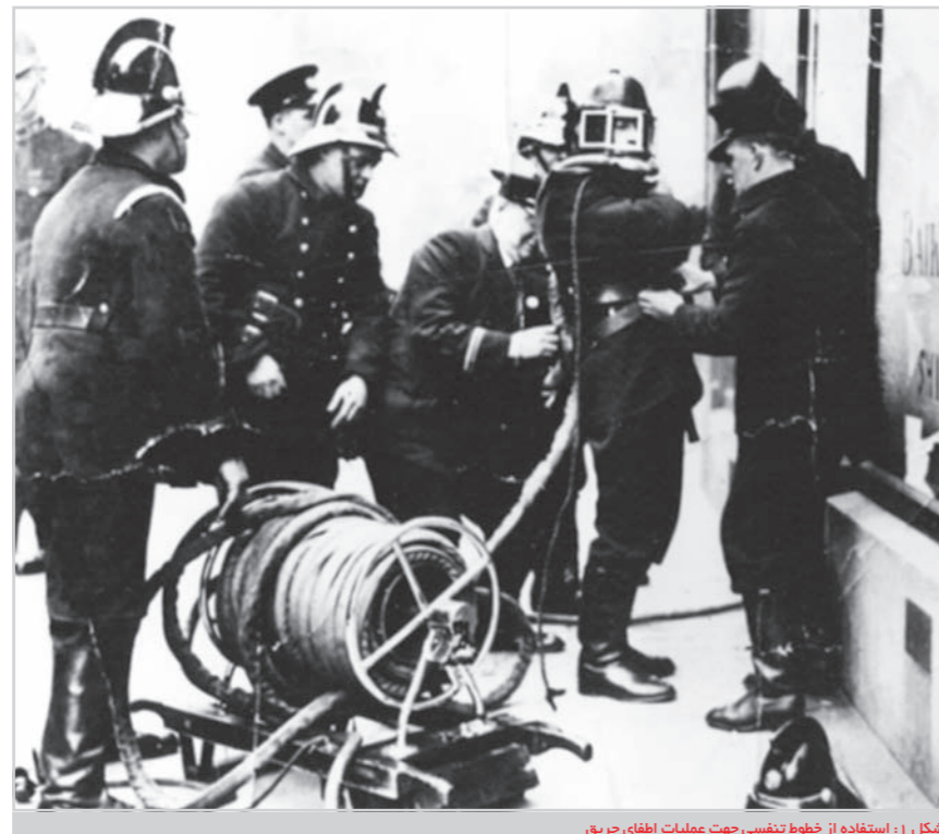
شکل ۱: استفاده از خطوط تنفسی جهت عملیات اطفای حریق
