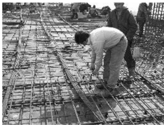
آرماتوربندی در حالت چمباتمه و پایین
