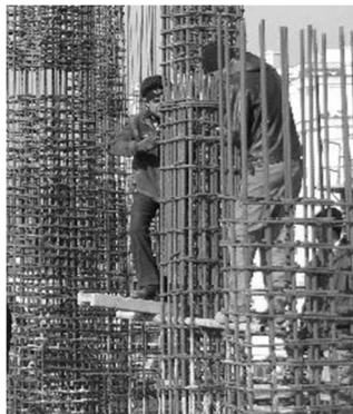
آرماتوربندی ایستاده و در ارتفاع شانه
