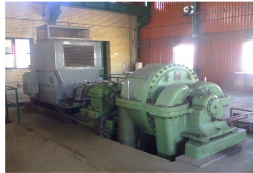
شکل ۵- دستگاه دمنده هوا و سه قسمت الکتروموتور، گیربکس و کمپرسور
