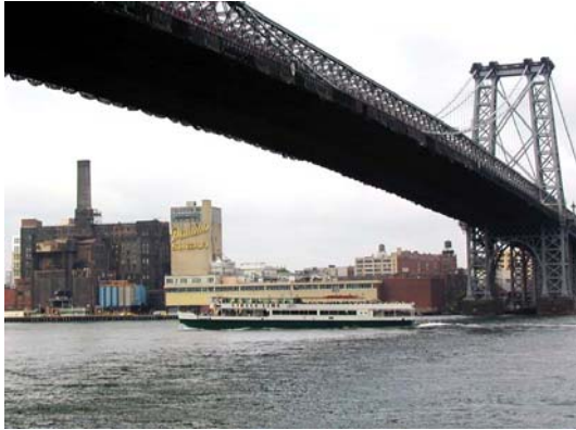
تصویر ۶- پل ویلیامزبرگ، مانهاتان (۳۰)
