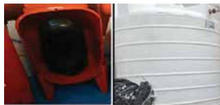
تصویر سمت راست مخزن ذخیره و سمت چپ منبع دیافراگمی (راش شده جهت نمایش دیافراگم درون آن)
