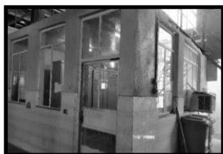
شکل ۴- نمونه مداخلات کنترل صدا در اتاق کنترل واحد تولید؛ سمت راست بعد از اصلاح و سمت چپ قبل از اصلاح
