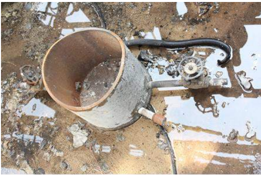
BOX-12 تهیه شده جهت نصب در محل نشت MDEA در
