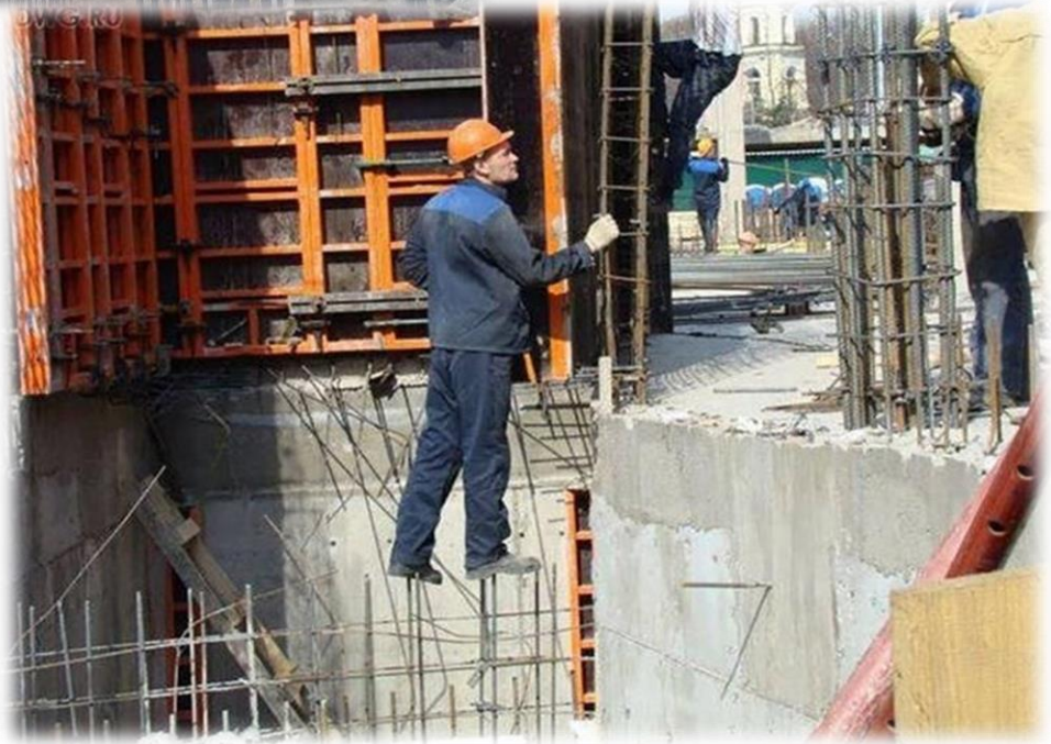
نمونه ای از کارهای نایمن در آرماتوربندی
