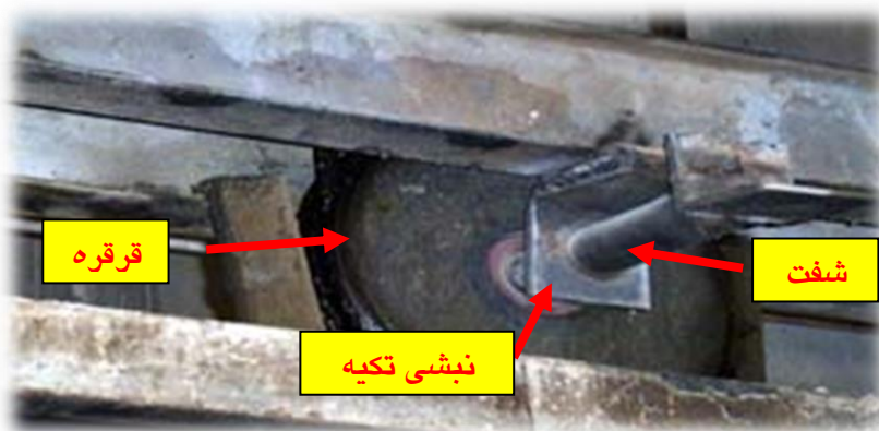
شکل ۶- قرقره، شفت و نحوه استقرار آنها در بالای کابین
