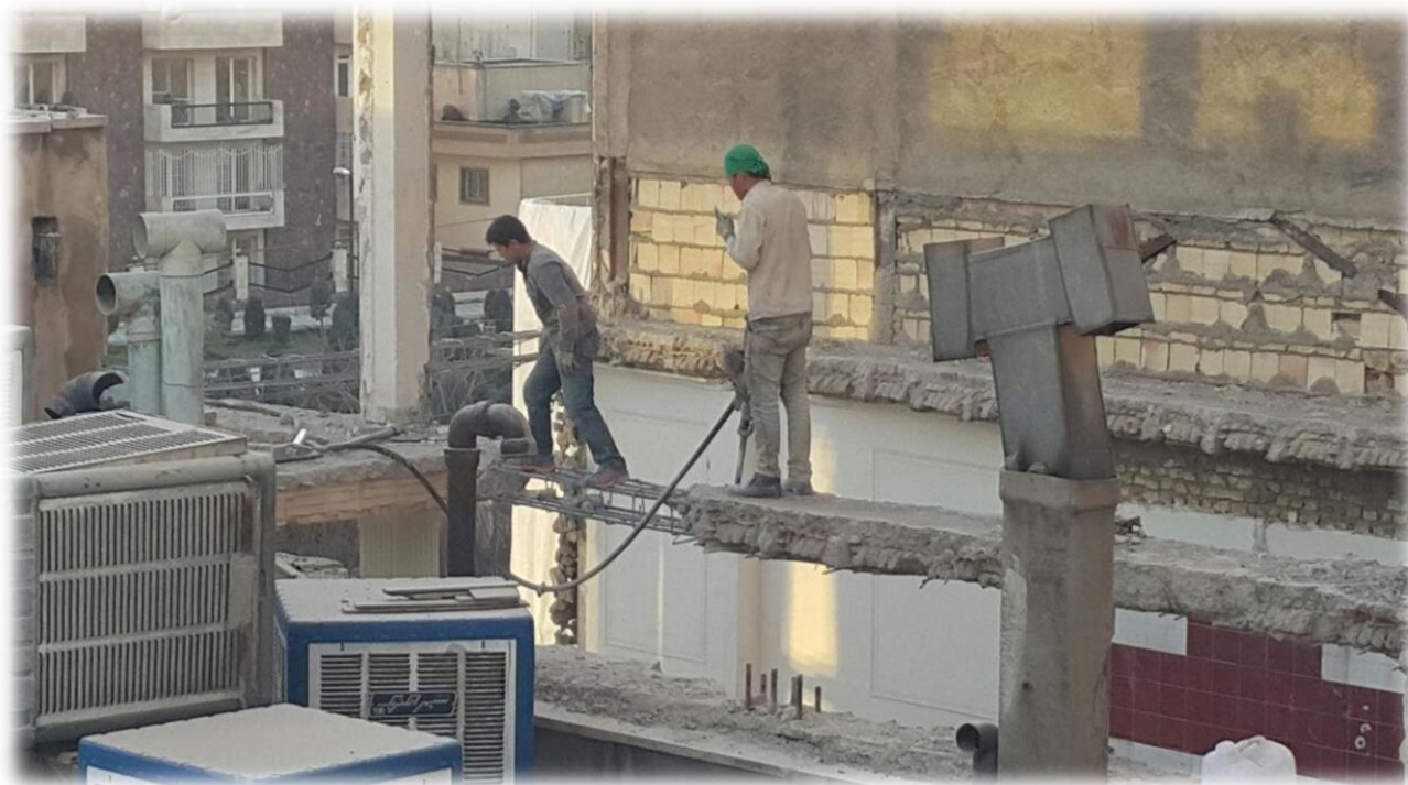
نمونه‌ای از عملیات تخریب ناایمن
