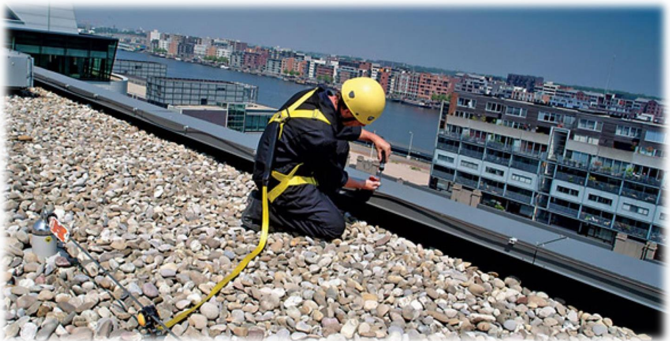
نمونه ای از تجهیزات حفاظت در برابر سقوط
