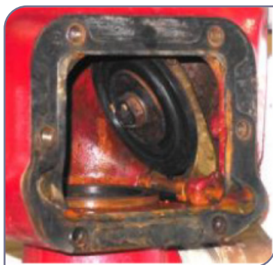
شکل ۱۲-۲. شیر سامانه‌ی خشک که نشان می‌دهد هنگام انجام آزمون بازشدن شیر، درپوش هوا در وضعیت "باز" قفل شده است.
