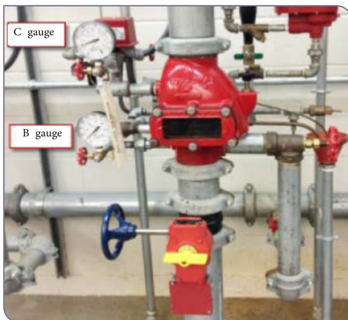
شکل ۱۰-۲. مکان قرارگیری فشارسنج‌های B و C در مجموعه‌ی سامانه‌ی خشک جهت انجام آزمون دبی در لوله اصلی تخلیه
