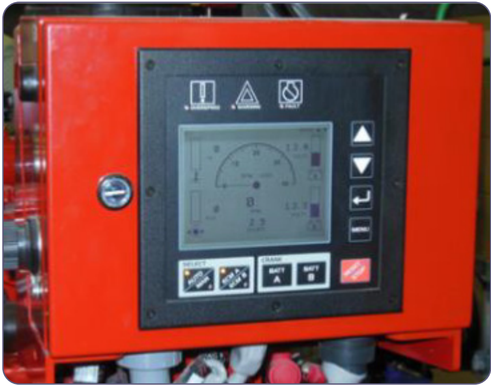
شکل ۱۴-۲. کنترلر الکترونیکی موتور دیزل با دکمه‌هایی برای راه اندازی باتری A یا B
