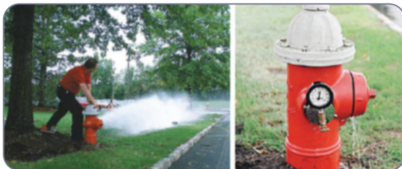
شکل ۹-۲. نصب فشارسنج (راست) و شستشوی هیدرانت R (چپ)
