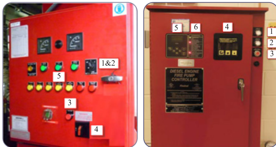
شکل ۱۷-۲. نمونه‌ی جعبه کنترل پمپ برقی (پایین): ۱- کلید راه اندازی موتور از طریق باتری A، ۲- کلید راه اندازی موتور از طریق باتری B، ۳- کلید خاموش کردن موتور، ۴- صفحه‌ی شیشه‌ای که با شکستن آن حالت خودکار -دستی و برعکس موتور انتخاب و موتور تست می‌شود، ۵- صفحه نمایش LCD، ۶- لامپ‌های LED نشان‌دهنده وجود مشکل، جعبه کنترل پمپ دیزلی (بالا): ۱- کلید راه اندازی موتور از طریق باتری A، ۲- کلید راه اندازی موتور از طریق باتری B، ۳- کلید خاموش کردن موتور، ۴- کلید قطع جریان برق AC، ۵- لامپ‌های نشان‌دهنده وجود مشکل.
