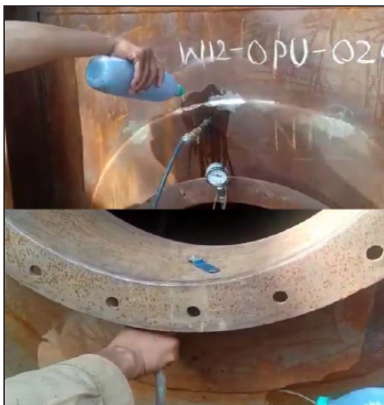
شکل ۳-۳. ورق تقویتی و مراحل تست پد هوا
