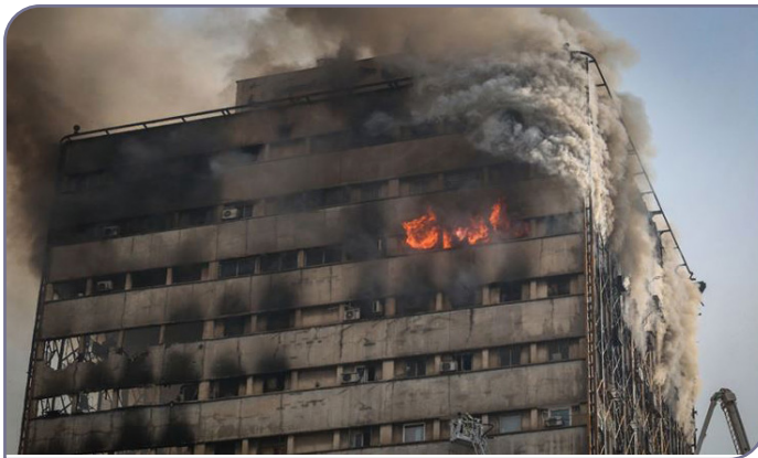
شکل ۱-۴. حادثه آتش‌سوزی پلاسکو
