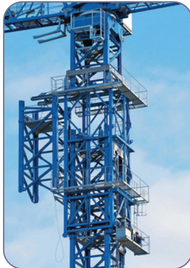
شکل ۲-۲. جرثقیل برجی در حال افزودن سکشن ارتفاعی
