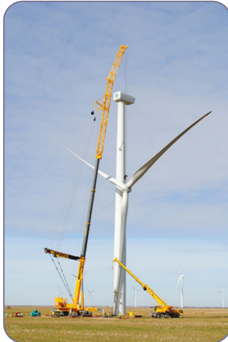
شکل ۹-۲. نصب پره توربین بادی به کمک جرثقیل متحرک
