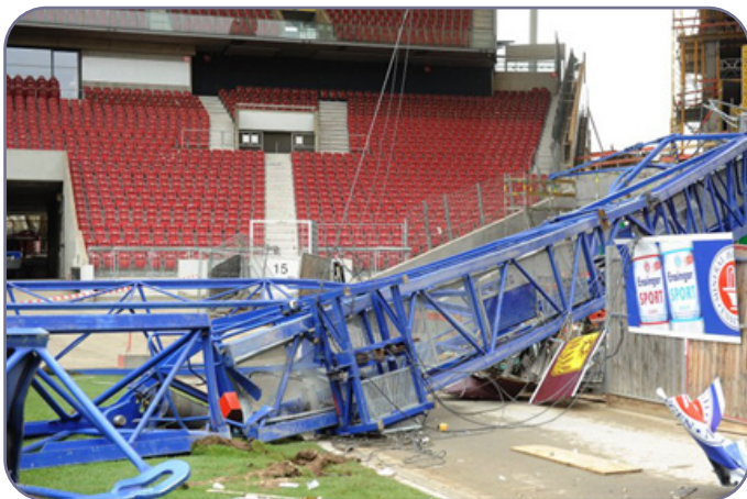
شکل ۷-۸. تصاویری از سقوط بوم و کابین جرثقیل برجی در استادیوم ۴۰۰۰۰ نفره اشتوتگارت
