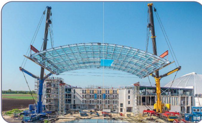
شکل ۲۲-۳. استفاده از دو جرثقیل متحرک جهت جابجا کردن بار
