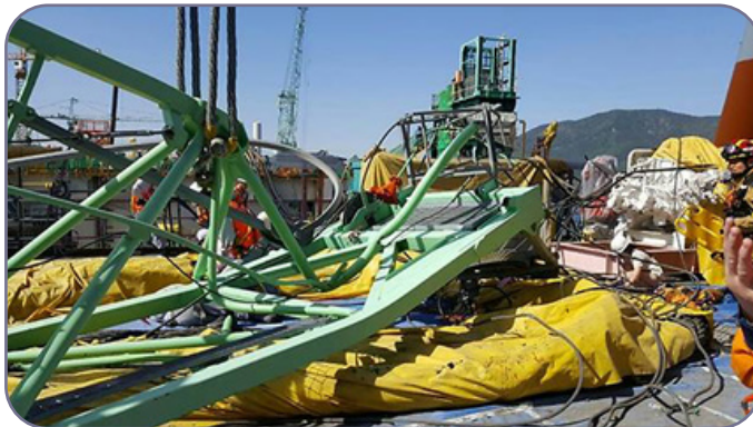
شکل ۷-۷. حادثه سقوط جرثقیل در کارخانه کشتی‌سازی سامسونگ در کره جنوبی
