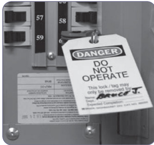
۱-۲-۶. نمونه‌ای از قفل کردن با آیدی تگ
