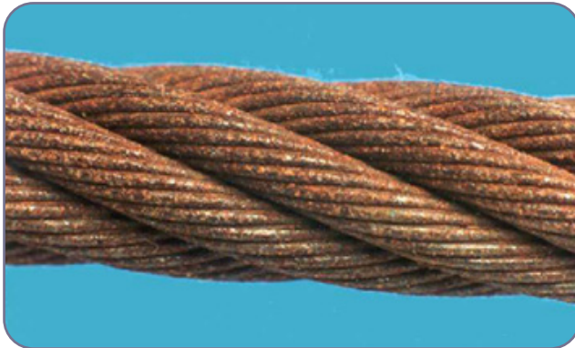
شکل ۳-۳۸. نمای بزرگ‌نمایی شده از زنگ‌زدگی خارجی سیم بکسل
