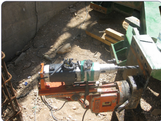
شکل ۱-۳. استفاده از دستگاه برقی و دوار فرسوده و درپوش فلزی به جای درپوش عایق و احتمال برق گرفتگی
