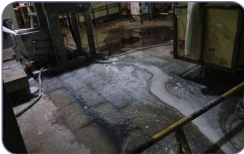
شکل ۱.۹. وجود مواد لغزنده در کف کارگاه
