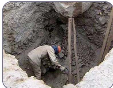
شکل ۱.۸. عدم ایمن‌سازی محل انجام کار
