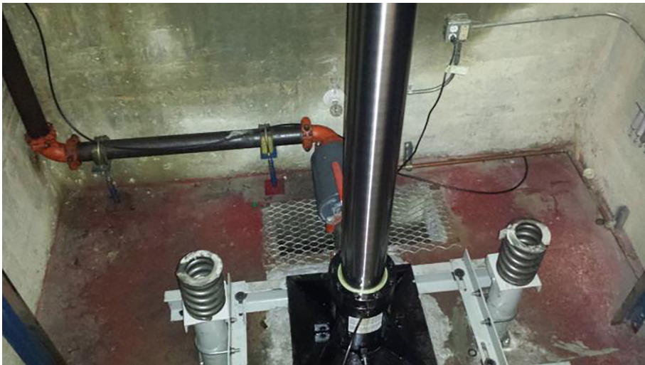
شکل ۳-۷۶. جک آسانسور هیدرولیک
