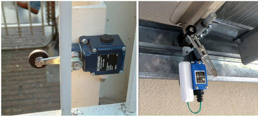
شکل ۳-۲۶. دو نمونه کلید حد نهایی آسانسور
