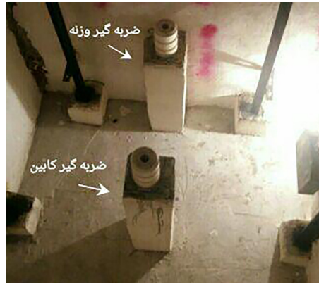
شکل ۳-۲۰. نحوه نصب ضربه گیر در چاهک
