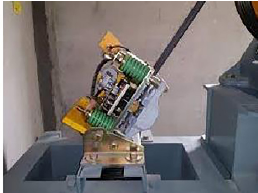
شکل ۳-۲۴. نمونه وسایل ایمنی حفاظت از اضافه سرعت و حرکت ناخواسته کابین
